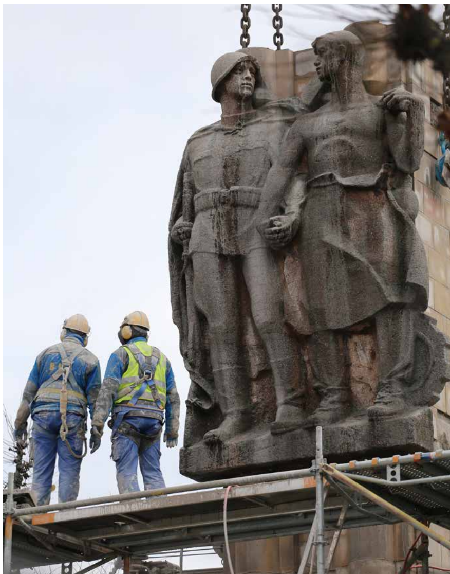
Rozbiórka pomnika Wdzięczności dla Armii Radzieckiej w centrum Szczecina (listopad 2017)
